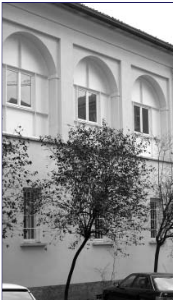
Figura 4. Il lato perimetrale con le finestre dell'antico convento
