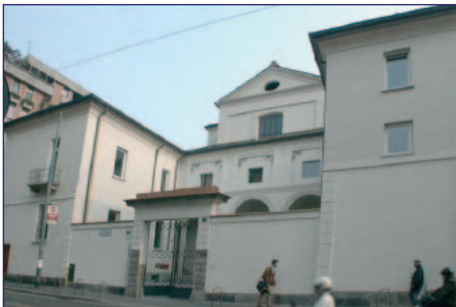
Figura 2. Il complesso dopo il restauro da via della Moscova
